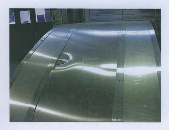
On observe une déformation du remplissage central au droit des couvres – joints et arceaux, sans incidence sur les remplissages périphériques.
